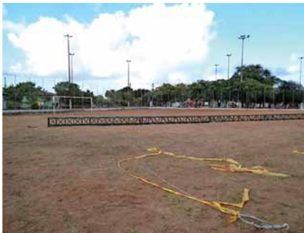
Na Zona Norte da cidade, um fato deixou a população perplexa: a estrutura de ferro da árvore natalina - de 60 metros de altura, que estava sendo montada - tombou porque os parafusos da base de sustentação da haste principal foram arrancados. A estrutura precisou ser refeita. Além do prejuízo material, a ornamentação demorou para ser concluída.
