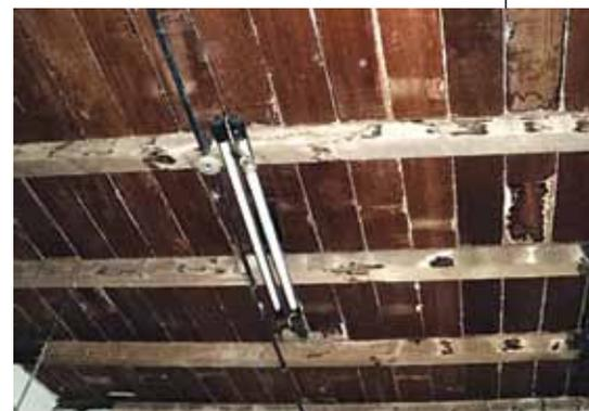
**Teto com tijolos aparentes, ameaçados por cupins**
