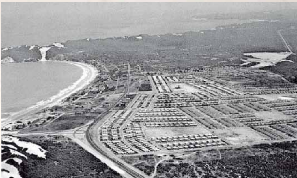
Pavimentação da avenida foi o início da urbanização do bairro de Ponta Negra
