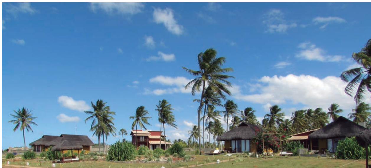
As primeiras casas do condomínio já estão prontas
