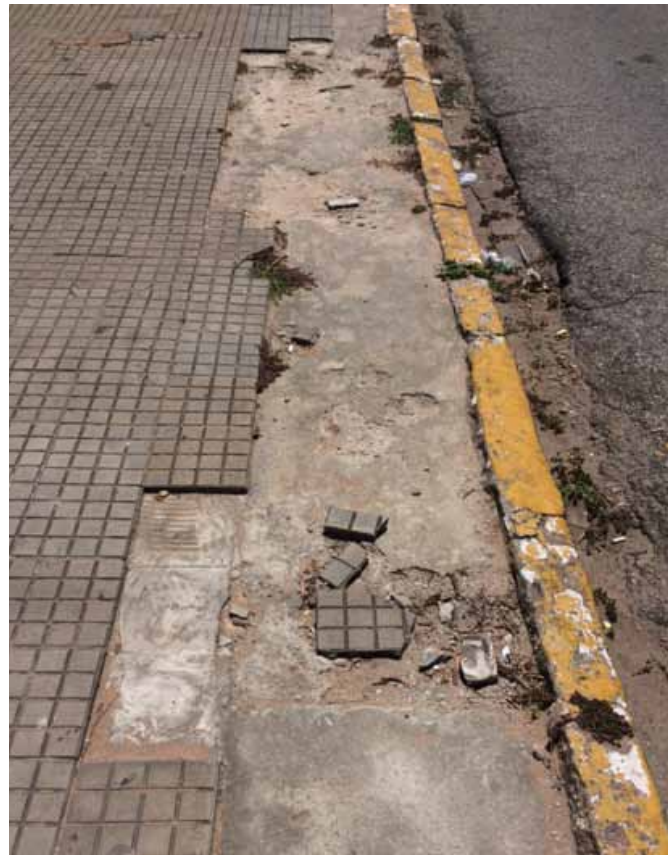
Projeto prevê demolição e recuperação de piso e canteiros
