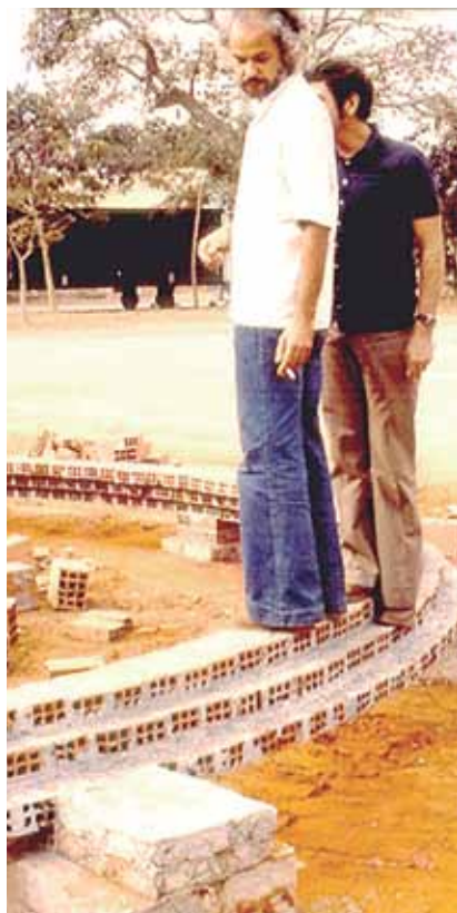
Fabrício durante as obras na Angola
