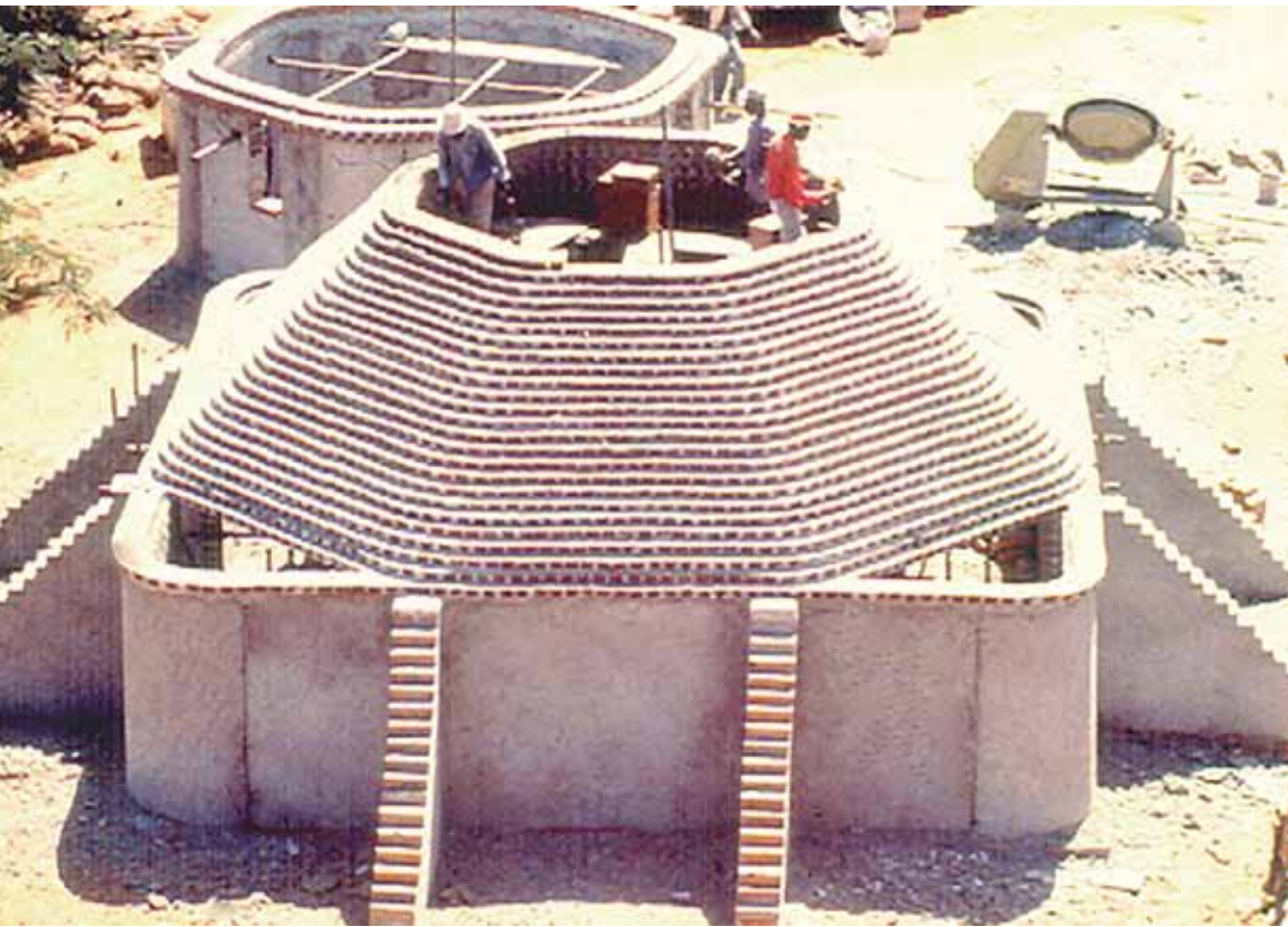
Construção de sala de aula na Angola
