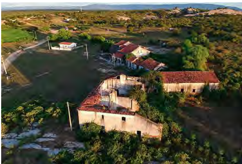
Casarão em ruínas
